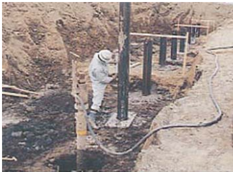
3. 鋼管立て込み
