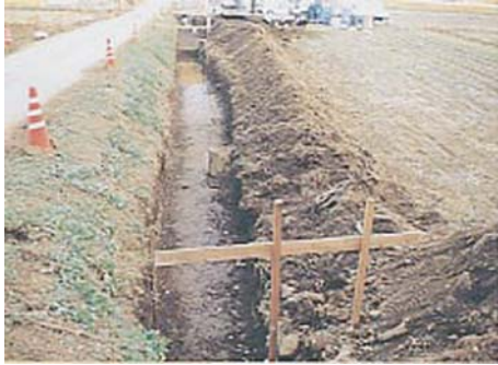
1. 床付・杭芯位置出
