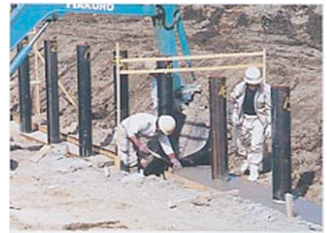
4. 均しコンクリート打設
