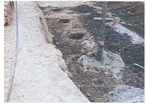
2. 柱状地盤改良体築造
