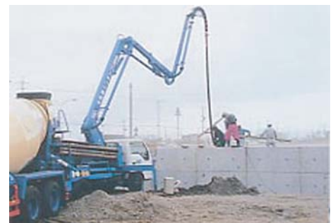
6. 中詰コンクリート打設
