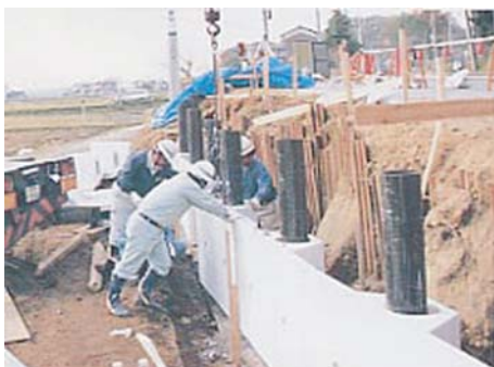
5. パネル取り付け
